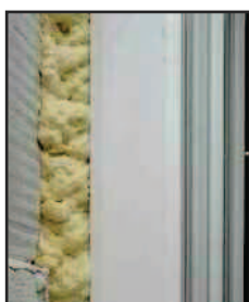
Mise en œuvre simple et rapide avec un pistolet injecteur.
